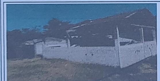
Foto 5: Sustrución de laminas por laminas troqueladas calibre 26
