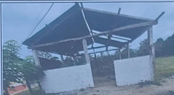
Foto 1: Sustrución de estructura de soporte por madera por metal
